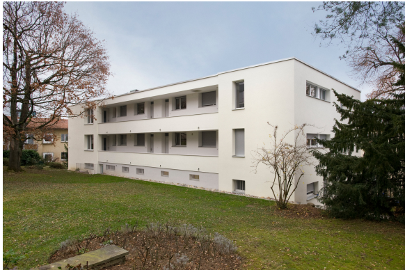
West- und Südfassade
