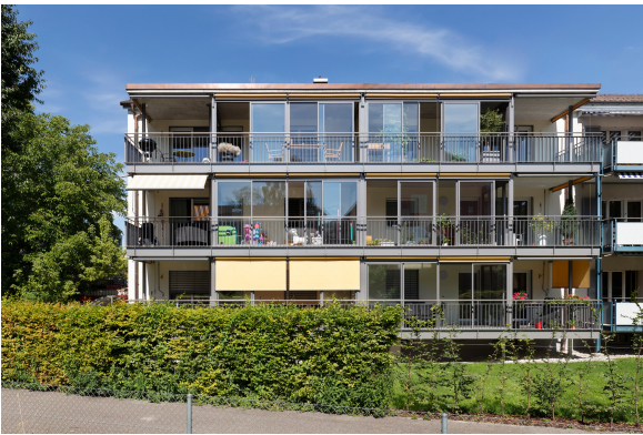
Fassade Südwest Neu
